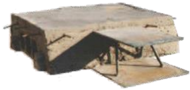
HEC POUTRE NON-APPARENTE
