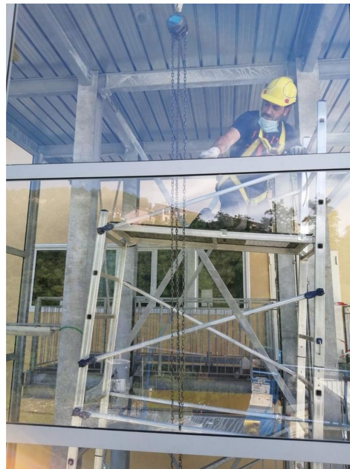
Escalier de sécurité avec système de protection solaire intégré - BUREAU DE FINCANTIERI - LA SPEZIA (SP)
