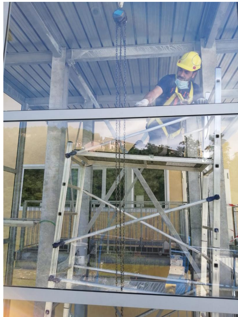
Scala di sicurezza con sistema frangisole integrato – SEDE FINCANTIERI – LA SPEZIA (SP)
